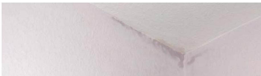
Bevorzugte Stellen im Raum sind hierbei die Fensterlaibungen, Stürze, Außenwanddecken. Auch innerhalb von Konstruktionen kann diese Tauwasserbildung auftreten. In jedem Falle wird die Bausubstanz mehr oder minder geschädigt und bei lang anhaltenden Feuchtebelastungen finden die in der Luft befindlichen oder an den Bauteilen anhaftenden Pilzsporen günstigen Nährboden für erneutes Wachstum.
